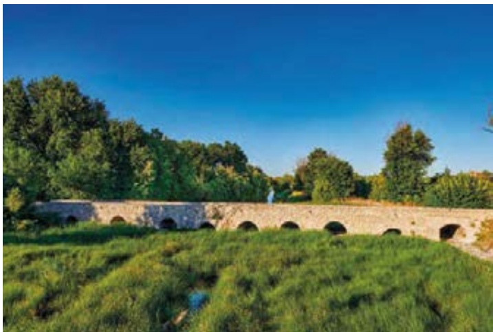
Villarta de San Juan. Puente romano.
