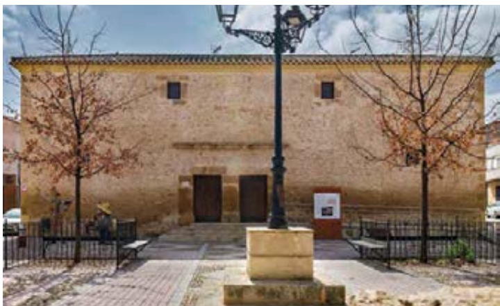
Argamasilla de Alba. Pósito de la Tercia.
